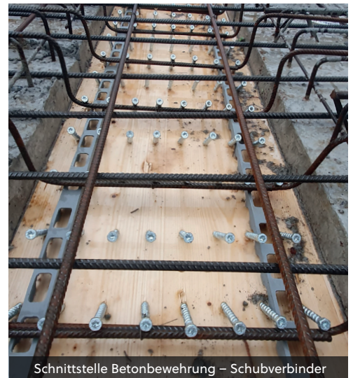
Begehbare und wettersichere Abdeckung der Verbundschrauben möglich
